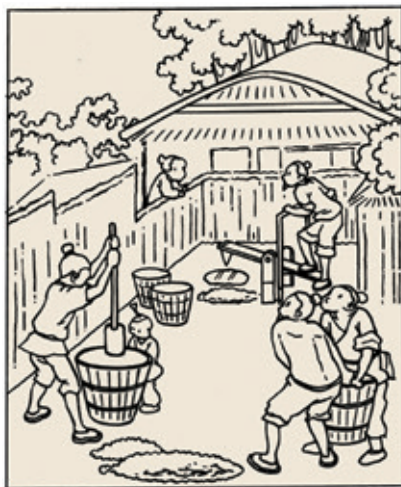
图 11-1-11 古代捣谷的舂和用来在井上汲水的桔槔(摘自《天工开物》)
