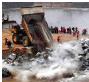
图 11-5-10 力大无穷山河动——三峡截流实验中，是机械巨人把滚滚长江分成两截
