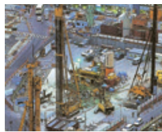
(d) 打桩机将重锤举高
