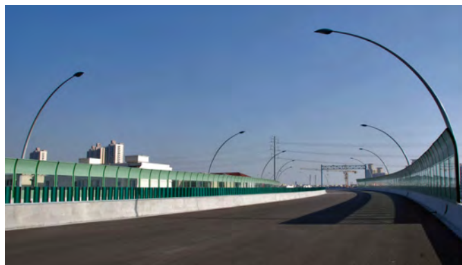
图 3-23 道路两旁的隔音墙
