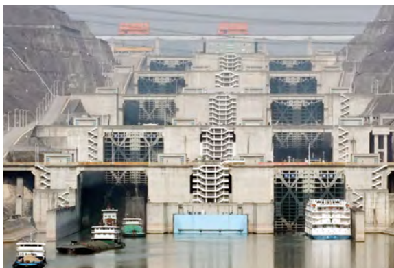
图 8-26 三峡五级船闸
