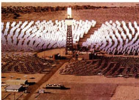
图 18-12 太阳能发电装置
