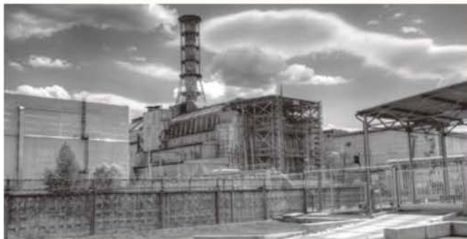
图 18-7 切尔诺贝利核电站发生事故后,4号核反应堆被钢筋混凝土封闭起来
