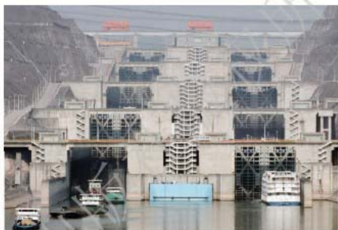
图 8-26 三峡五级船闸
