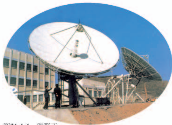
图21.4-4 碟形天线用来接收来自卫星的信号
