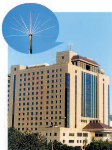
图19.3-5 现代建筑上的避雷针
