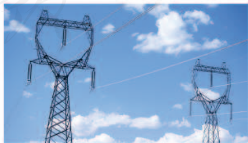
图19.3-6 高压输电铁塔最上面有两条防雷的导线
