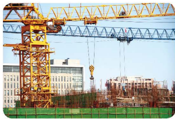
图 10.1-6 工地施工现场
