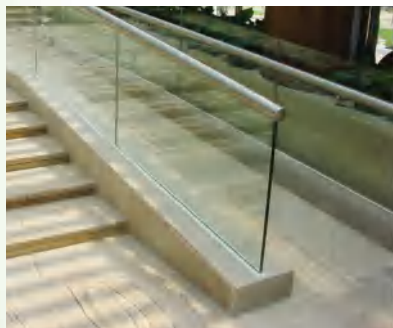
(a) 供轮椅通行的斜坡(右侧)
