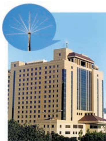
图 19.3-5 现代建筑上的避雷针
