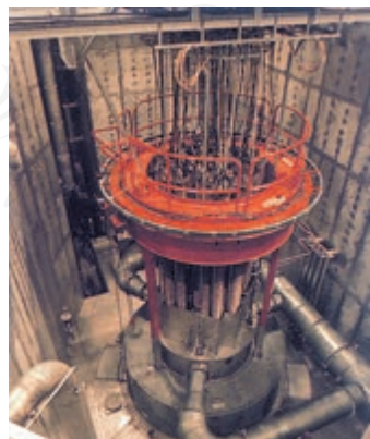
图 22.2-4 核电站中的反应堆
