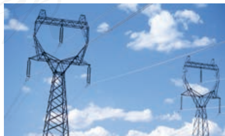
图 19.3-6 高压输电铁塔最上面有两条防雷的导线
