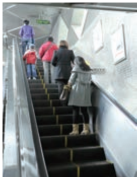
甲 运行中的自动扶梯
