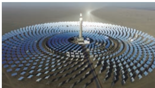
图4.3-5 塔式太阳能电站
